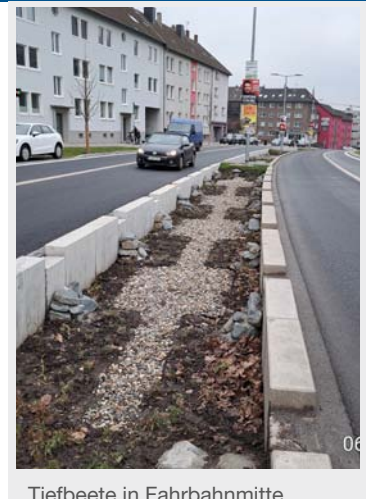
Tiefbeete in Fahrbahnmitte
