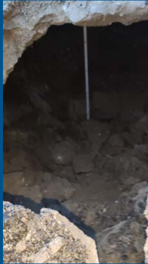
Oben: Schadensbild des schwer geschädigten Betonkanals, aufgenommen im Rahmen der veranlasseten Kontroll-Inspektionen
