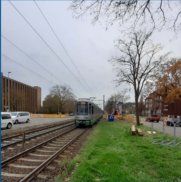
Baufeld mit Bahnbetrieb in der Vahrenwalder-Straße, Bereich „Alter-Flughafen“
